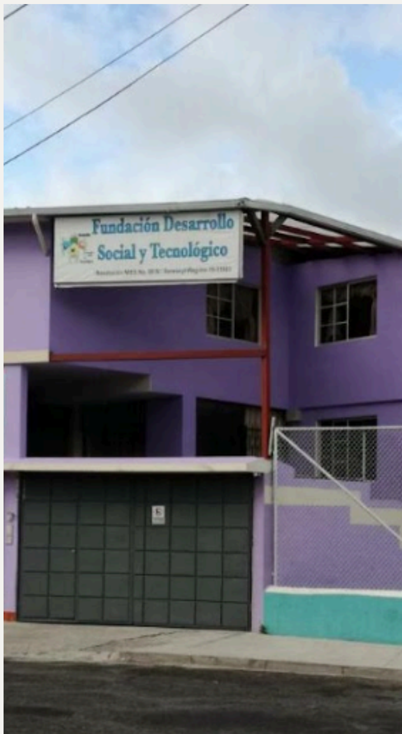
El Albergue Hotel FUNDESOTEC representa uno de los pilares de mayor impacto institucional.
